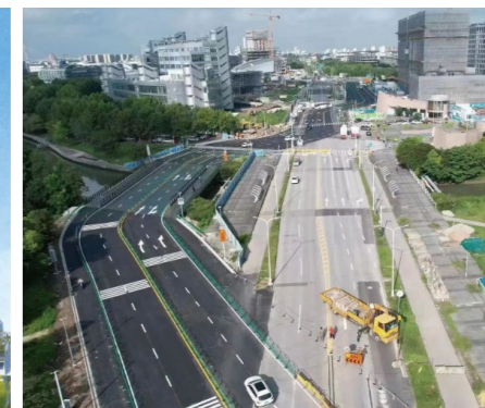
▲ 咨力守“沪”, 保障轨交23号线项目落地
