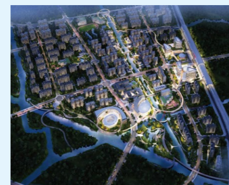
▲ 华新风溪城中村改造项目
