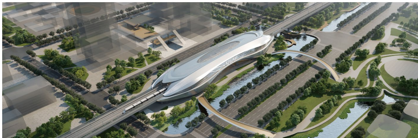
▲ 市域铁路两港快线东大公路站鸟瞰图
