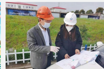
▲ 坚守不怠, 服务在G60科创云廊项目施工现场
